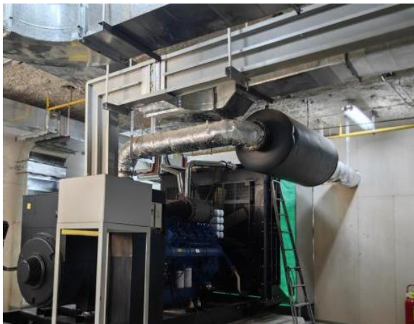
备用柴油发电机颗粒物捕集器
