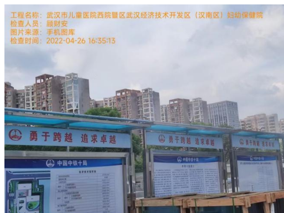
施工期管理制度
