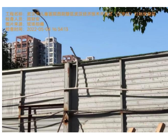
围挡及喷洒装置
